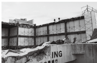
旧トマモール解体工事
